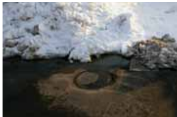
舗装された駐車場の下に地下水を流すことで、融雪効果を発揮する「エコRシステム」を導入
